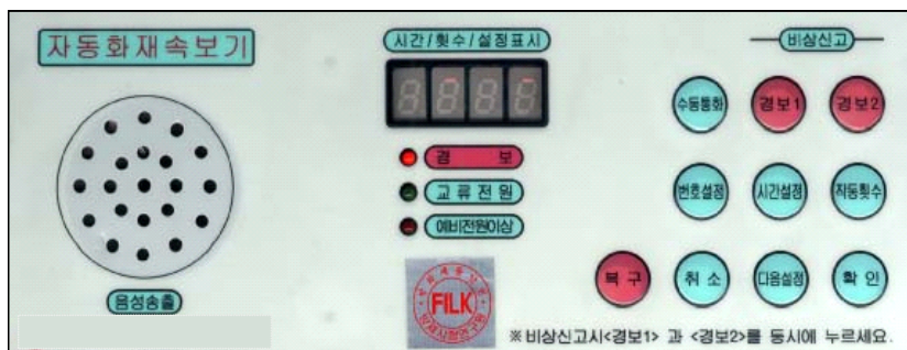
[ 그림 1-78 ] 자동화재속보기의 표시등 및 스위치
