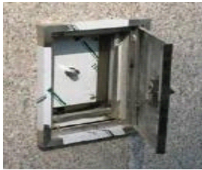
[ 그림 1-109 ] 무선기 접속단자함 및 분배기
