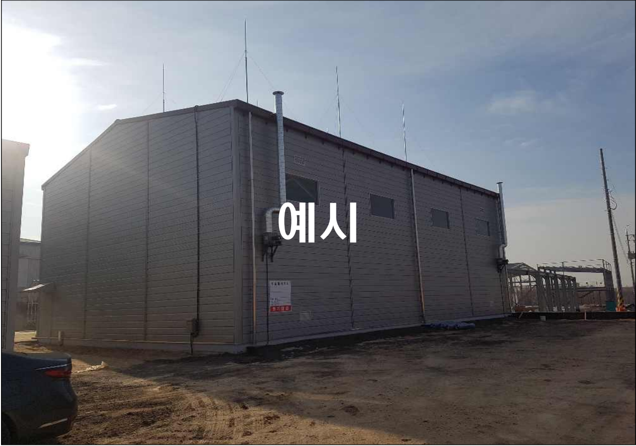
위험물 제조소등 현장 사진(좌측면)
