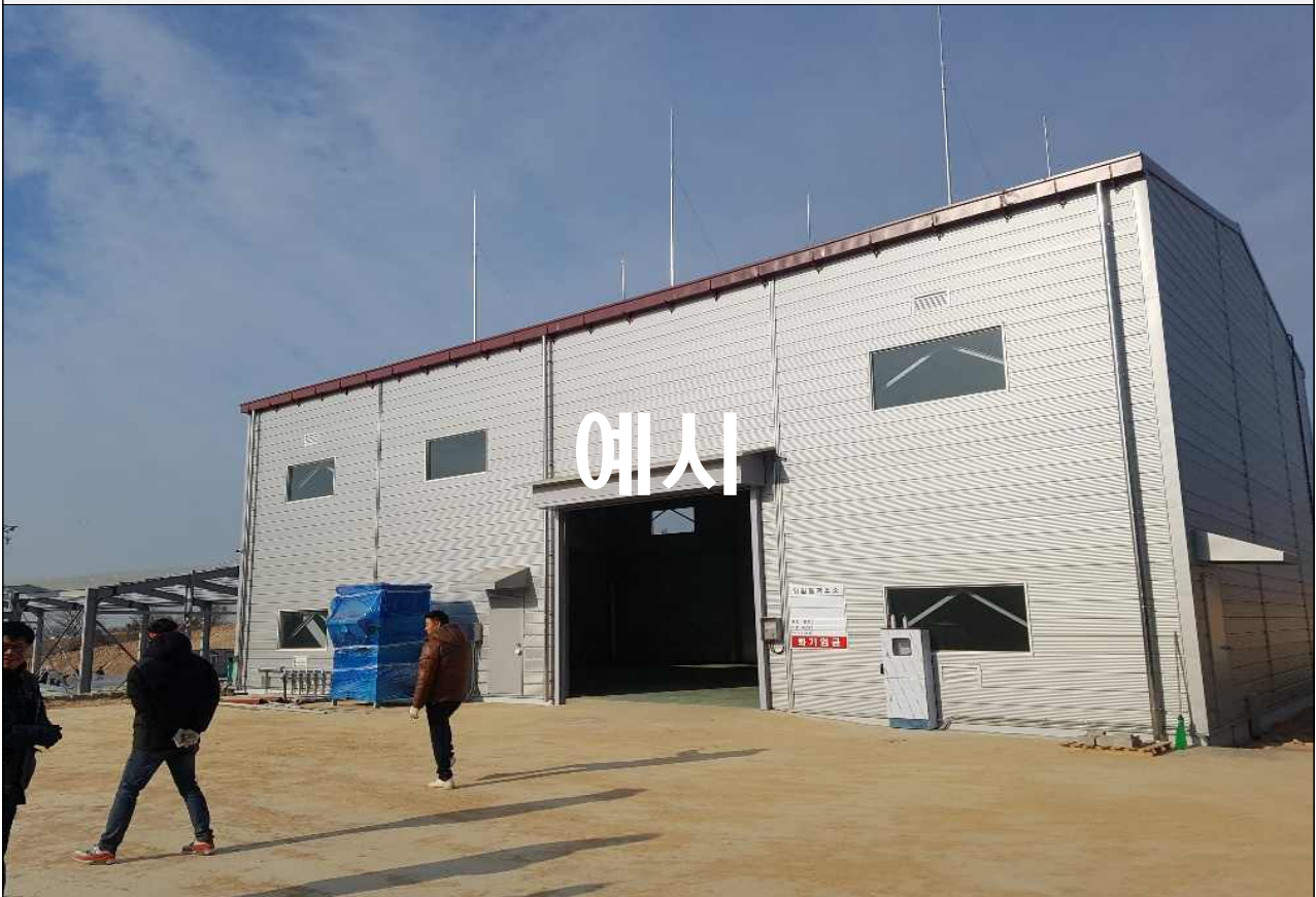
위험물 제조소등 현장 사진(전면)
