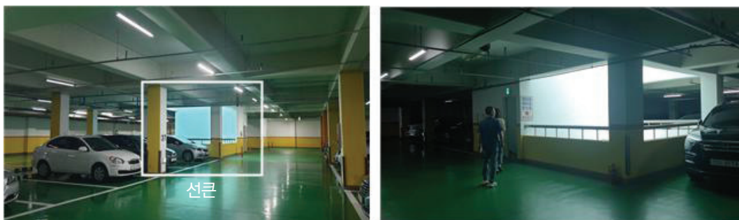
〈그림 23〉 선크이 설치된 지하주차장
