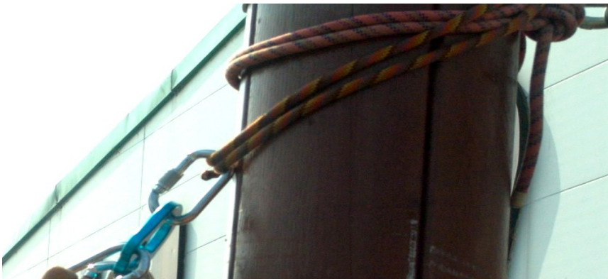
[그림 4-163] 확보로프 설치
