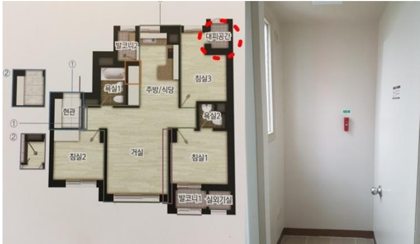
〈대피공간 방화문 설치〉
