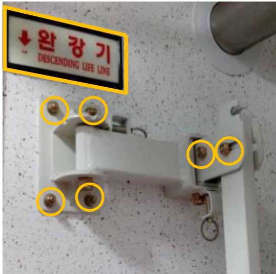
〈설치 및 체결 상태 확인〉
