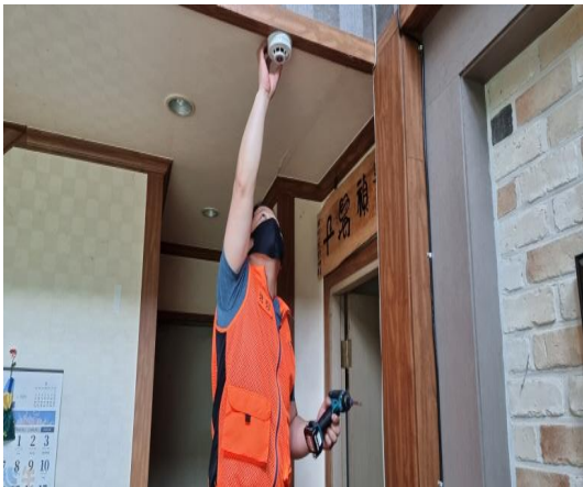
▲ 자상위가구 소방시설 설치(2021.5.6.)
