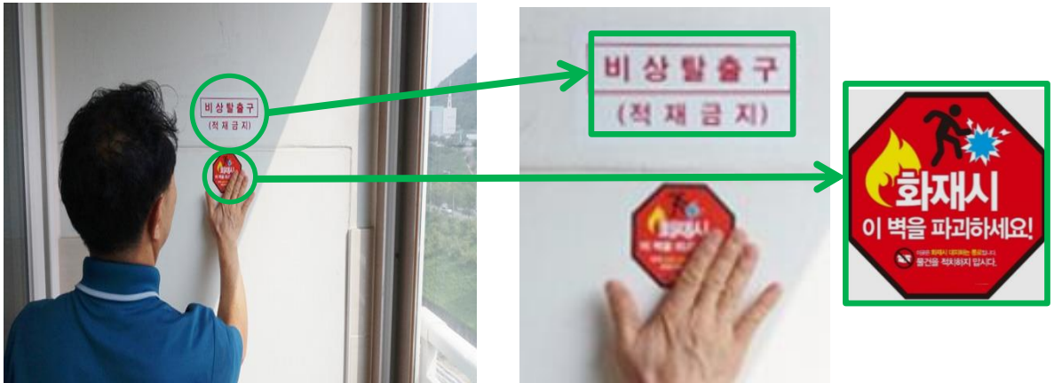
〈대피공간 방화문 설치〉
