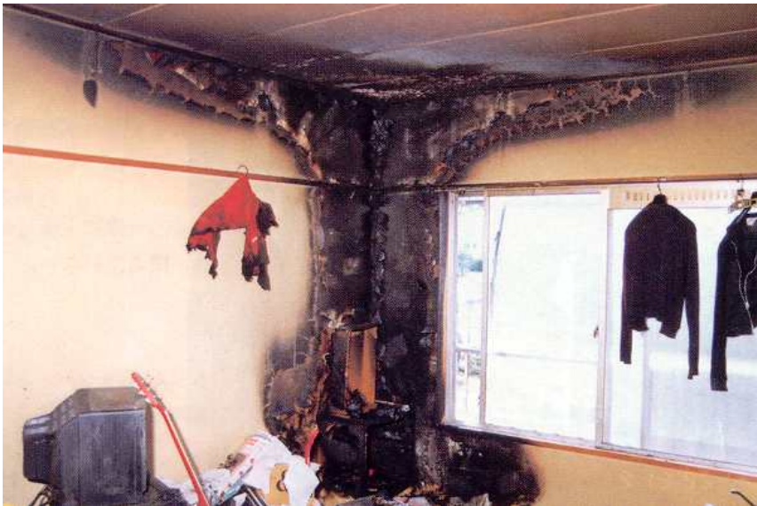
[ 그림 4-137 ] 평행형 (화염이 올라가서 천장에 도달하여 횡 방향으로 뻗고 있다.)
