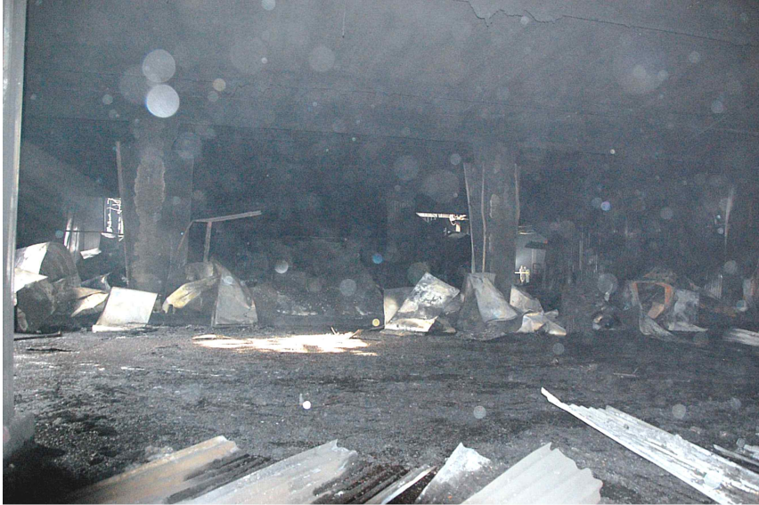
[ 그림 4-87 ] 12호 냉동실과 13호 냉동실의 경계벽으로 12호실 쪽으로 넘어져 있는 상황
