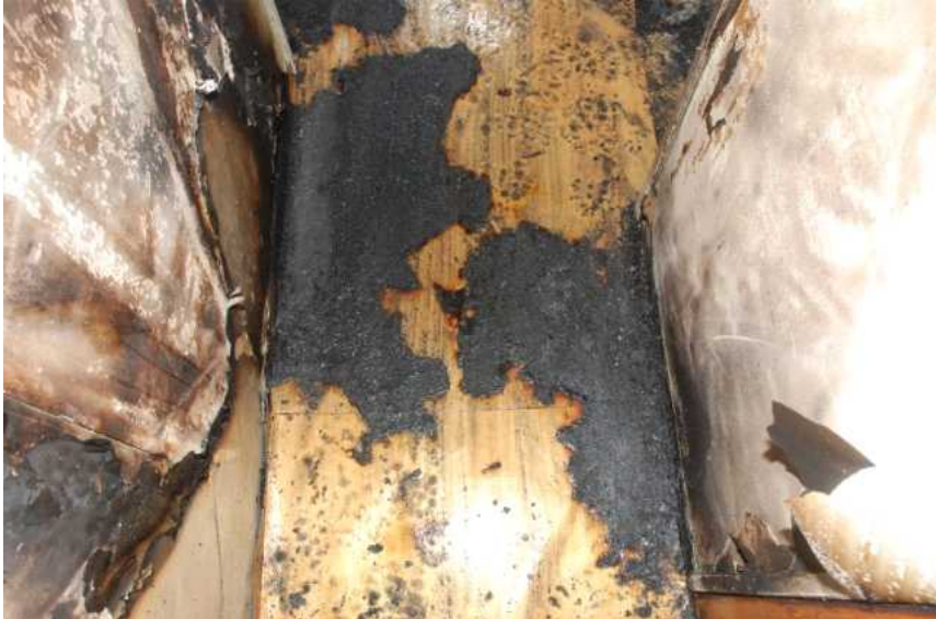
[ 그림 4-142 ] 연소촉진제 살포에 의한 바닥의 연소상황
