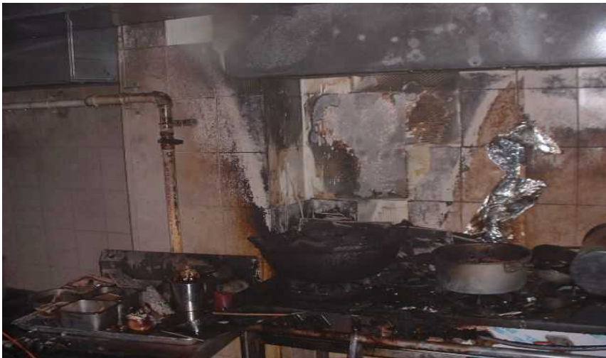
[ 그림 4-127 ] 식용유 과열로 인해 발생한 화재의 예 2
