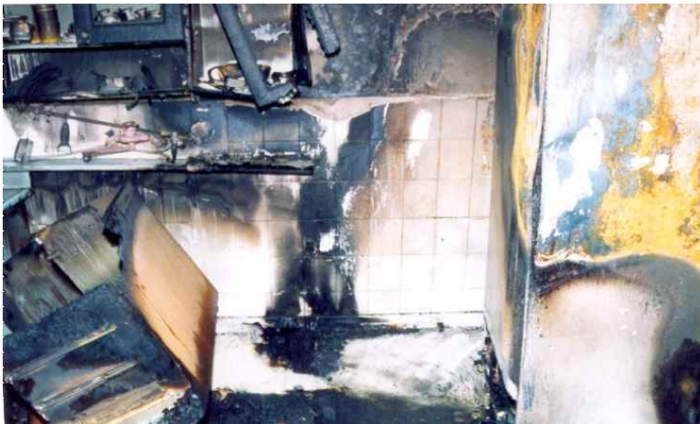
[ 그림 4-129 ] 냉장고 뒤쪽 벽면의 V패턴 (벽체매입콘센트를 중심으로)
