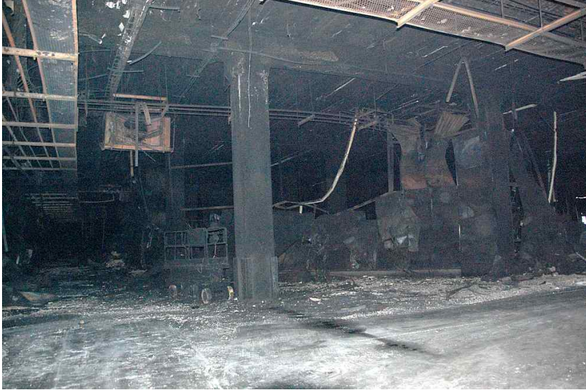
[ 그림 4-93 ] 교차통로에 면한 2호 냉동실의 벽체가 내측 방향으로 밀려나 파손된 상황
