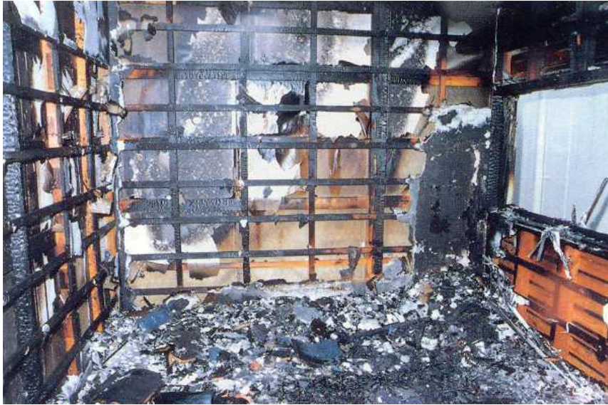
[ 그림 4-105 ] 내벽 - 좌측 안쪽의 하부 부근으로 부터 화염이 올라갔음이 확인된다.
