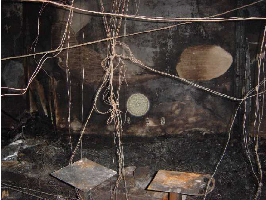
외관관찰 [ 그림 4-45 ] 폭열3 - 소파가 놓여 있던 곳의 벽 폭열 모습.
