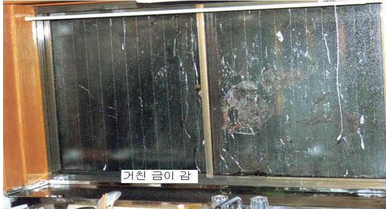
열영향2 [ 그림 4-53 ] 그림 4-52와 같은 건물의 유리창
