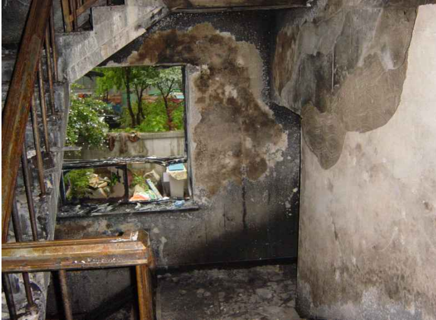
외관관찰 [ 그림 4-47 ] 폭열5 송파 노래방화재로 고시원으로 올라가는 계단벽면의 폭열된 모습.
