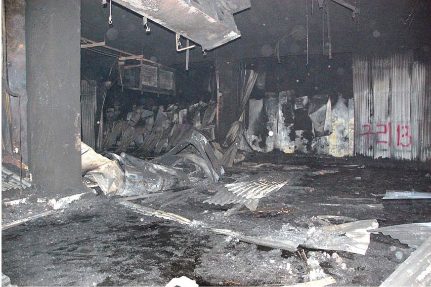
[ 그림 4-85 ] 13호실로 14호실과의 경계벽이 13호실 쪽으로 넘어져 있는 모습
