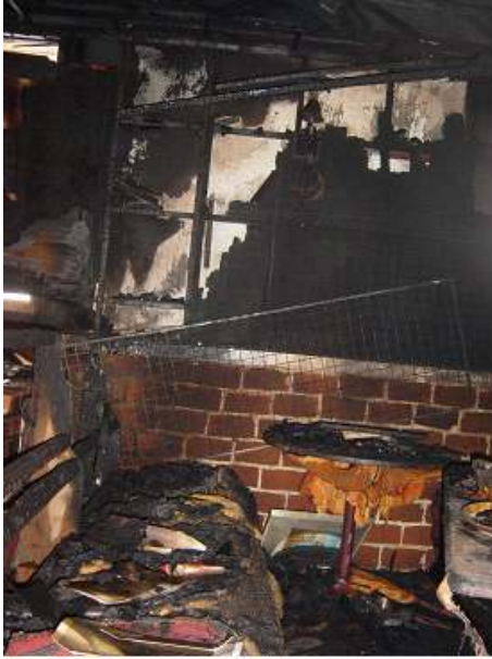
[ 그림 4-126 ] 무염연소 후 화재로 진전되어 나타난 역삼각형 패턴
