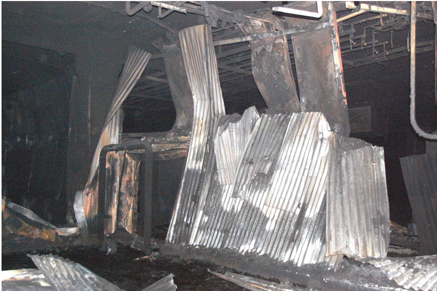
[ 그림 4-84 ] 13호실 통로측 벽으로 통로 쪽으로 기울어져 있는 모습
