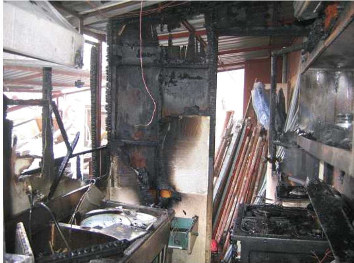
[ 그림 4-128 ] 전자레인지로 중심으로 올라간 화재 패턴
