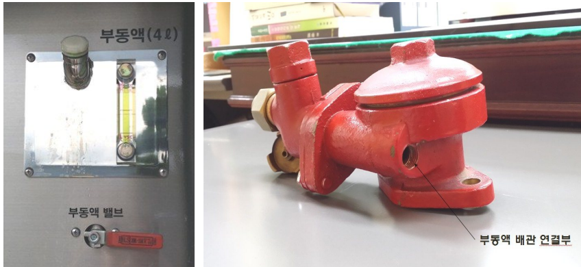
[ 그림 3-65 ] 부동액 탱크 및 지수밸브 부동액배관 연결부
