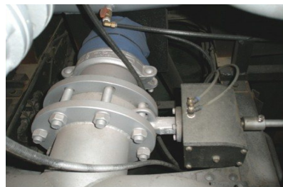
[ 그림 3-11 ] 복동식실린더 및 밸브실린더 일체형 액추에이터
