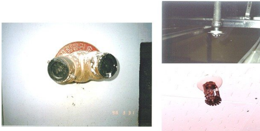
[그림 7-3] 스프링클러 송수관 및 헤드의 설치 예
