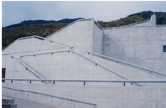
[그림 4-4] 철근콘크리트 건축물
