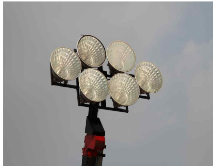
조명등 점등, 파손 여부 확인
