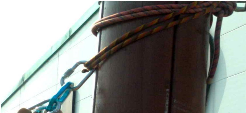
[ 그림 4-163 ] 확보로프 설치
