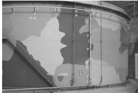
[ 그림 3-21 ] 물분부설비의 설치 예
