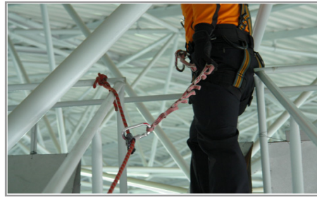
[그림 4-61] 안전줄을 이용한 자기확보
