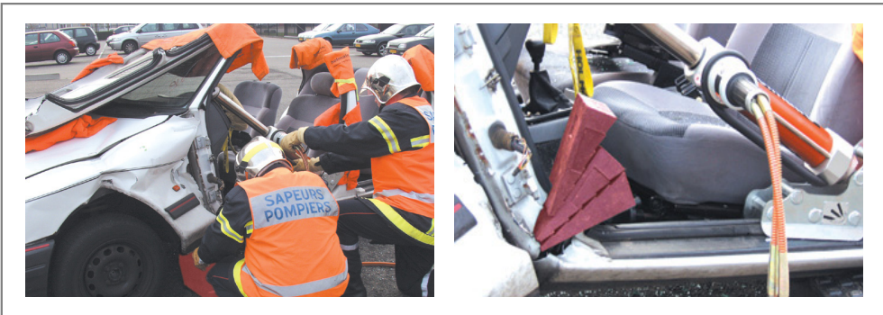
[그림 4-190] 계기반 전방이동 방법으로 공간을 확보
