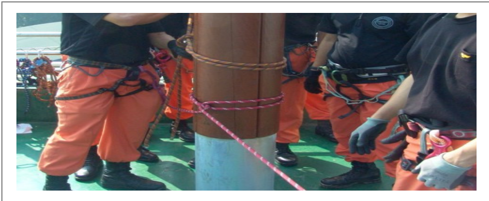
[그림 4-162] 가로로 설치된 안전확보로프
