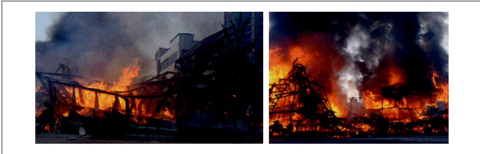
[그림 1-15] 화재시 철골구조의 변형 및 파괴
