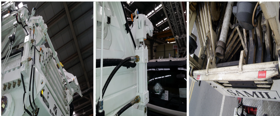
유압의 누유 및 손상여부 확인, 신장 시 해제되고 수축/안착 시 잠기는지 확인
