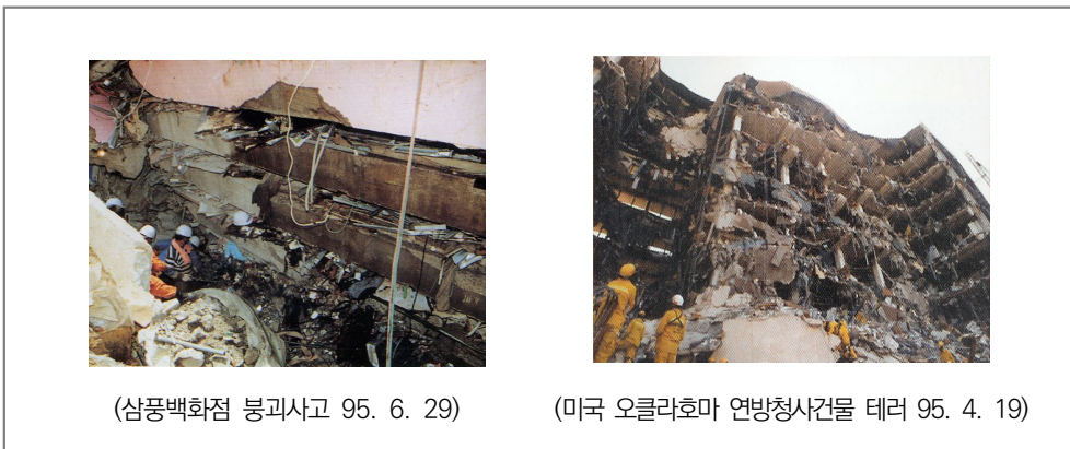
[그림 5-90] 전형적인 팬케이크형 붕괴 [그림 5-91] 캔틸레버형 붕괴
