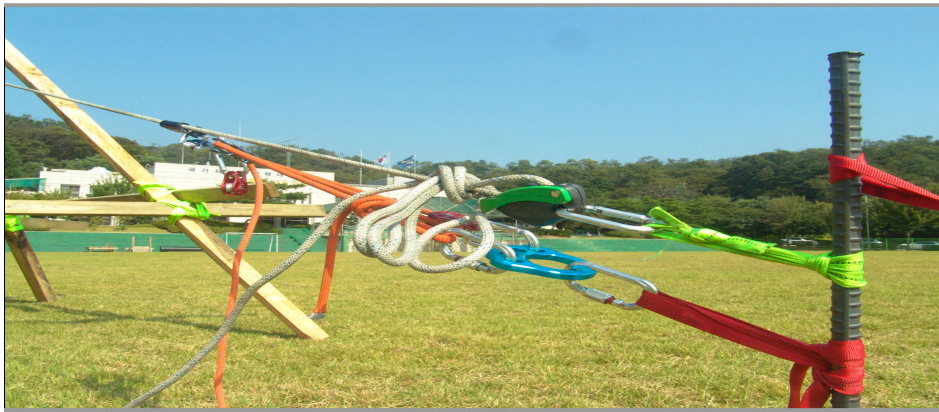
[그림 4-68] 인공말뚝 · 삼각대 · 당김장치 운용방법
