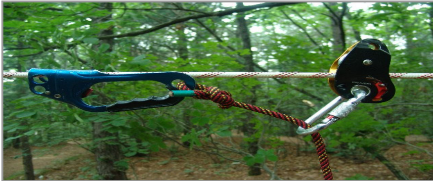
[그림 4-138] 진입장치 설치
