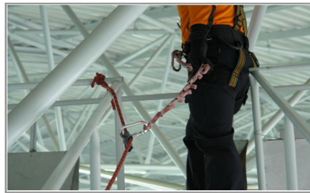
[그림 4-62] 안전줄을 이용한 자기확보
