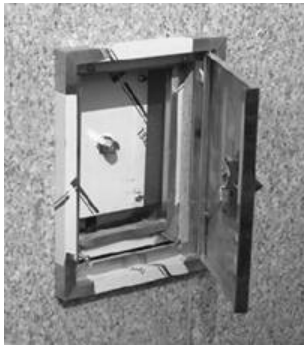
[그림 4-7] 무선기 접속단자함 및 분배기
