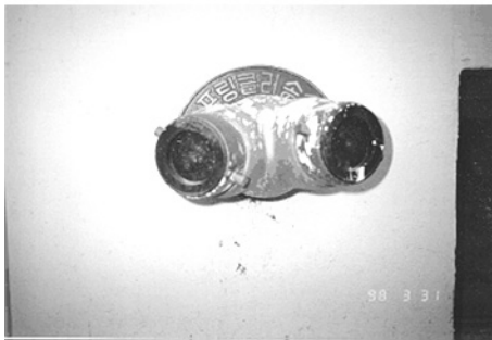
(스프링클러 송수관 및 헤드의 설치 예)
