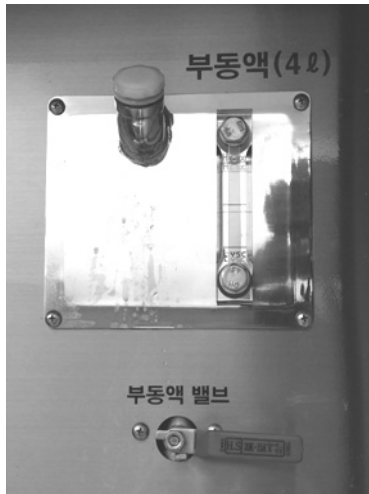
(그림63 - 부동액 탱크 및 지수밸브 부동액배관 연결부)
