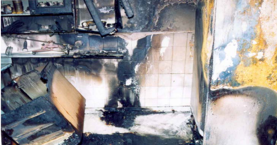
〈사진32〉 냉장고 뒤쪽 벽면의 V패턴(벽체매입콘센트를 중심으로)
