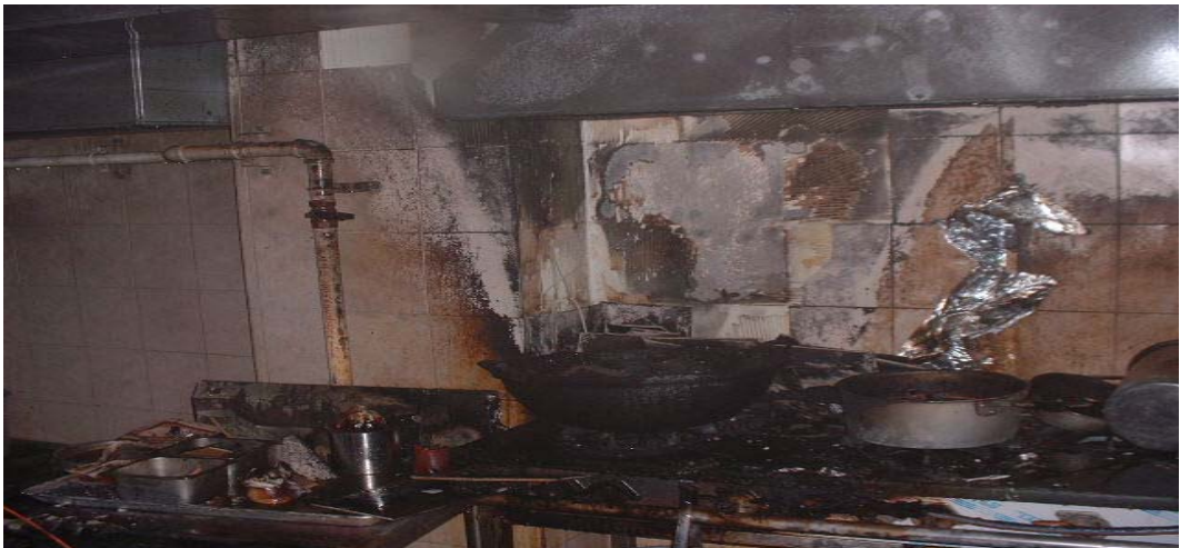
〈사진30〉 식용유과열로 인해 발생한 화재의 예 20)
