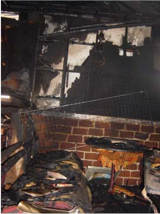
〈사진29〉 무염연소 후 화재로 진전되어 나타난 V-shaped Pattern
