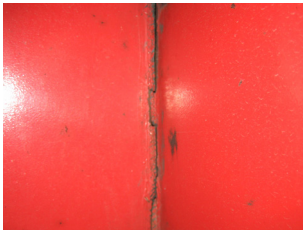
균열 발생 예
