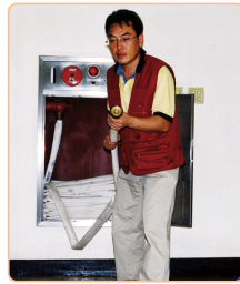
옥내소화전 밸브를 연다. ▶ (시계반대방향으로 돌림) ※ ON-OFF방식의 경우 스위치를 별도로 작동시킨다.
