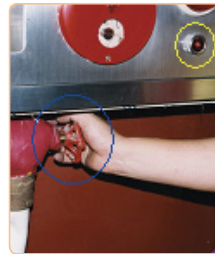
옥내소화전 밸브를 연다. ▶ (시계반대방향으로 돌림) ※ ON-OFF방식의 경우 스위치를 별도로 작동시킨다.
