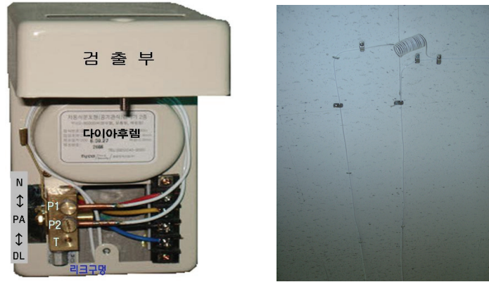
(검출부) (공기관) (그림 14) 공기관식분포형감지기의 구성요소
