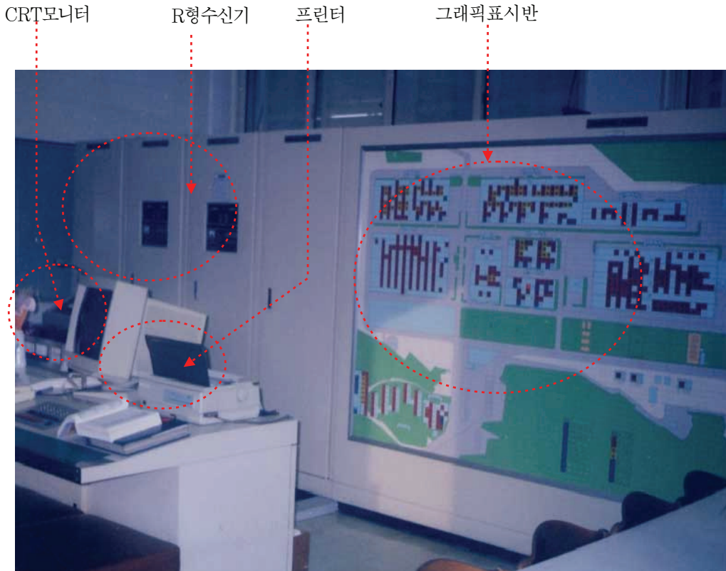
[그림 61] R형 시스템으로 구성된 방재센터
