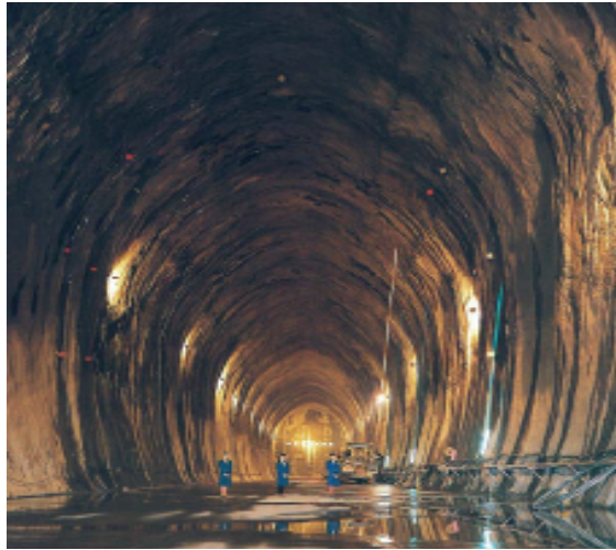
(그림 126) 암반탱크의 내부 구조
