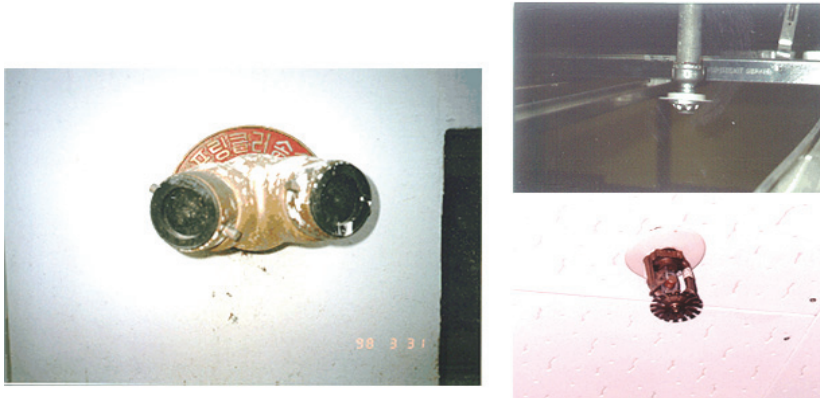
(스프링클러 송수관 및 헤드의 설치 예)
