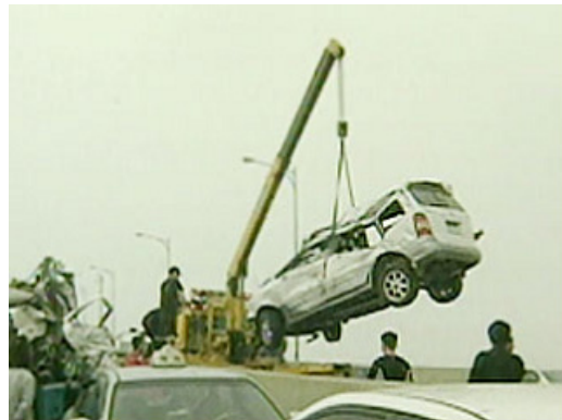
[그림 5-13] 크레인을 이용한 차량 인양
