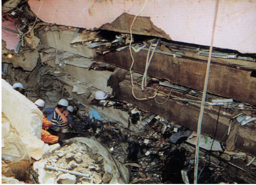
[그림 5-88] 전형적인 팬케이크형 붕괴 (삼풍 백화점 붕괴사고 95. 6. 29)
