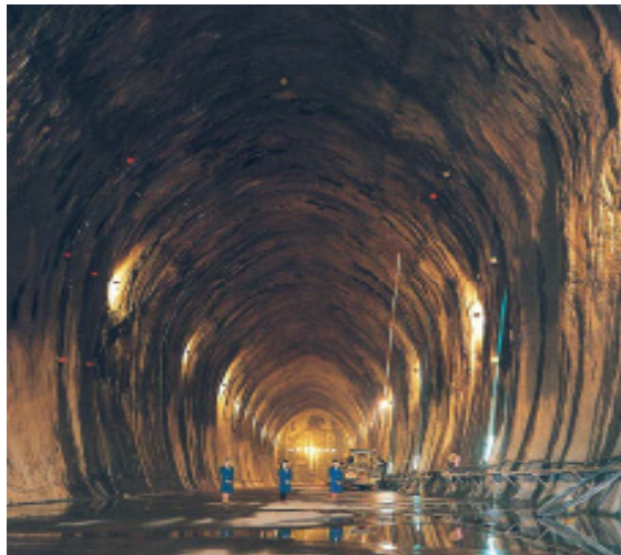
(그림 126) 암반탱크의 내부 구조
