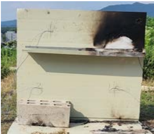
Fig. 24 Ignition point A.
